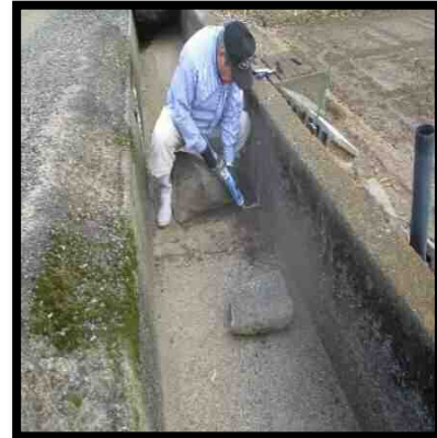
軽微な補修等 水路目地補修※直営・業者委託
