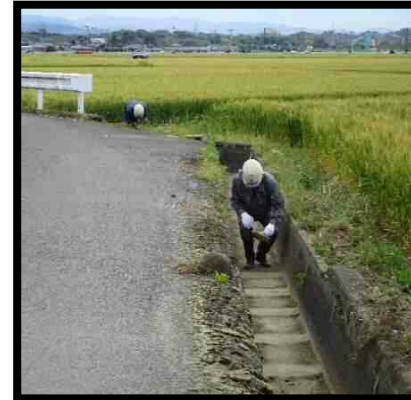
軽微な補修等 水路目地補修※直営・業者委託
