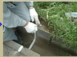
③混合した水中パテを手又はへら等ですり付けるように接着。 手で被覆する場合は、ゴム又はポリエチレン製の手袋を着用。
