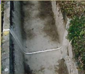
④養生。初期硬化は12時間程度。完全硬化は1~2週間程度。 材料によって硬化時間が異なる。 完全硬化までは過度な衝撃等与えない。
