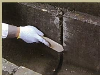
⑥コンクリートの壁面、底面の汚れをワイヤブラシ等で擦り取っておく。
