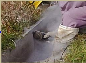
⑤ディスクグラインダーで目地やひび割れに切り込みを入れ、シーリング材が注入できる空間をつくる。
