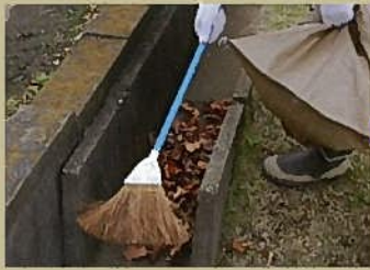
①水路内のゴミを撤去する。
