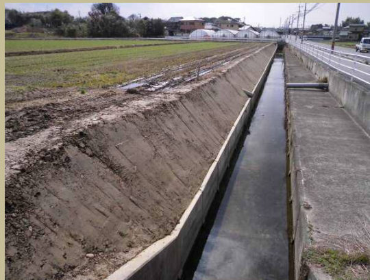
法面除草・整形後
