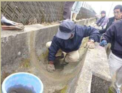
④モルタルを目地部にしっかりと入るようにゴム手袋で押しつけながら塗り込む。
