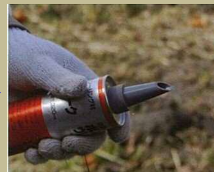
⑤シーリング材の口はカッター等で切断。斜めに切ったほうが目地に注入し易い。
