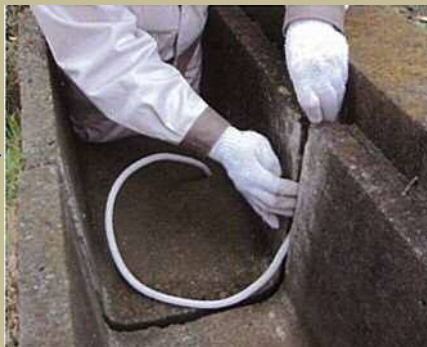
②目地のすき間が大きいときにはバックアップ材を充填する。
