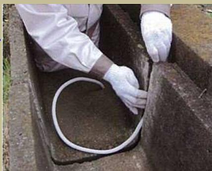
③目地のすき間が大きいときにはバックアップ材を充填。
