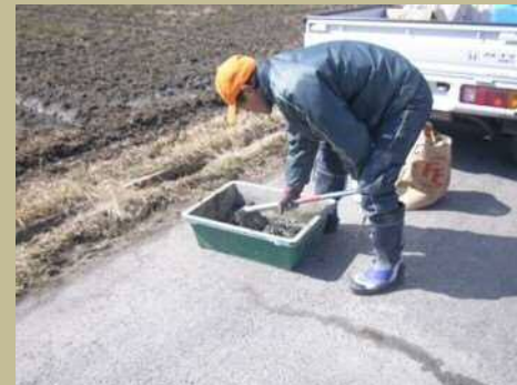
③モルタルを練り混ぜる。
