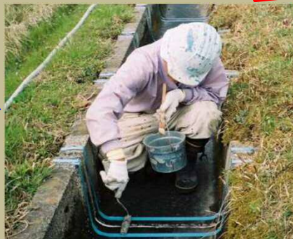
②補修範囲にプライマーを塗布。プライマーは、補修材に適合したものを使用。
