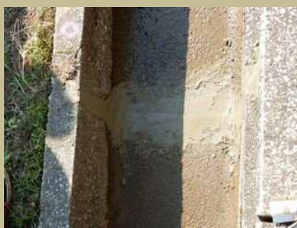
⑤モルタル充填完了。
