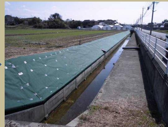
防草シート設置後
