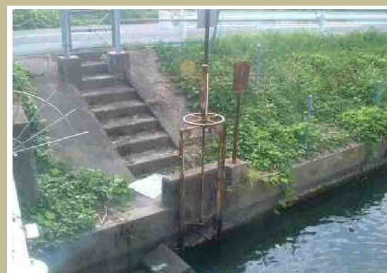
老朽化したゲート
