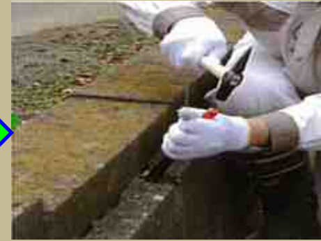
③目地のコンクリート片も取り除く。
