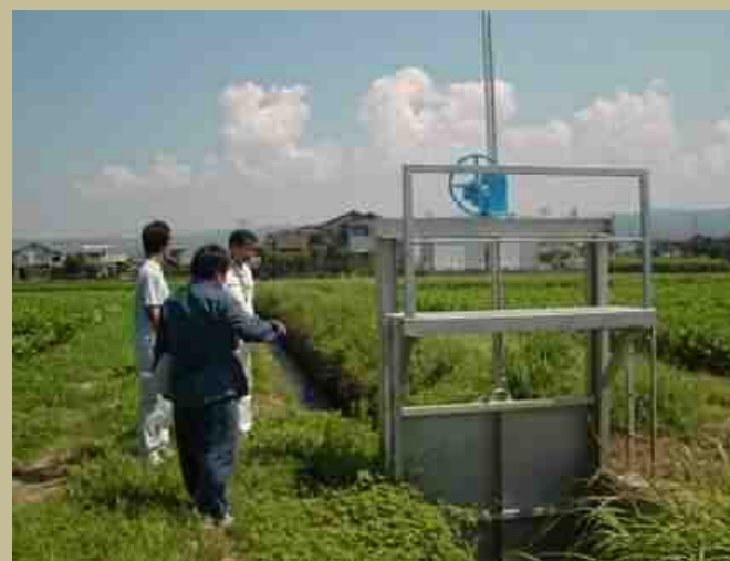
ゲート更新整備
