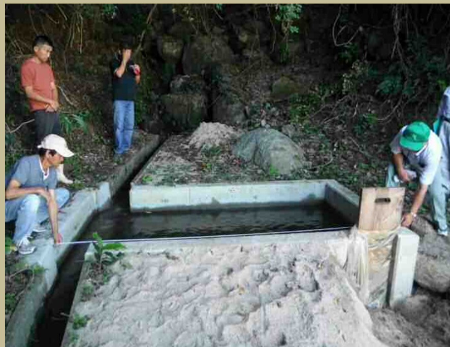
土砂溜め柵の改修
