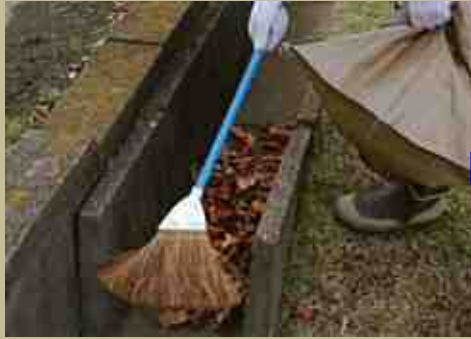
①水路内のゴミを撤去する。
