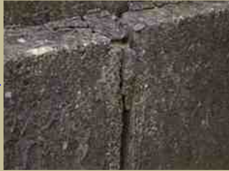
②目地まわりのゴミや詰められた物など、取れるものは全て取り除く。
