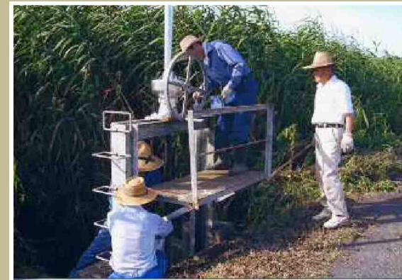
ゲートの点検
