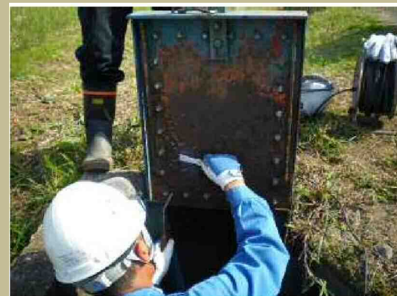
ゲートの補修状況
