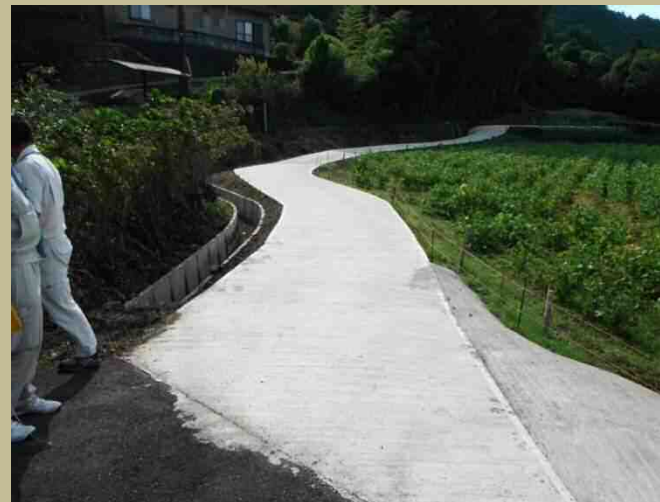
コンクリート舗装＋水路更新(自主施工)
