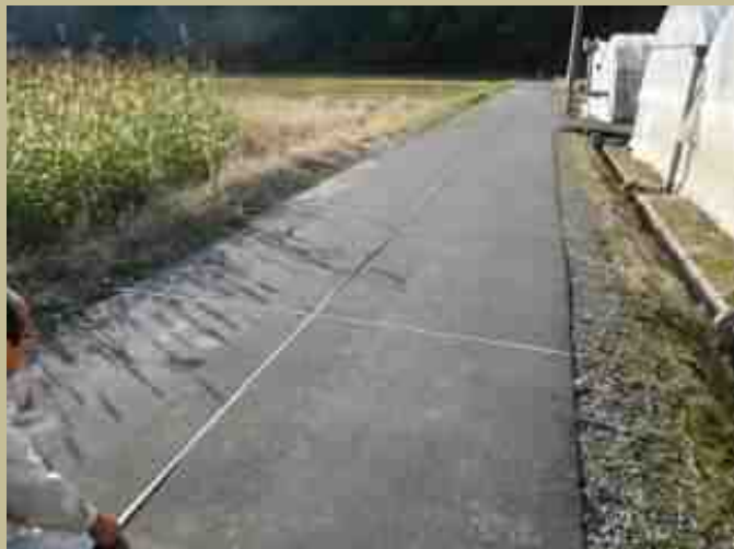
アスファルト舗装
