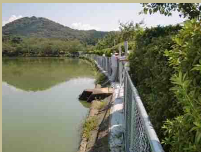
ため池防護柵整備
