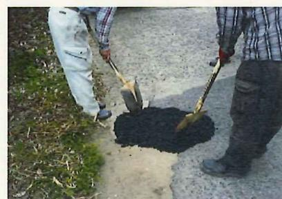
破損施設の補修 (点検つど)
