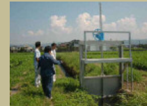
ゲート更新整備
