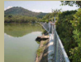
ため池防護柵整備
