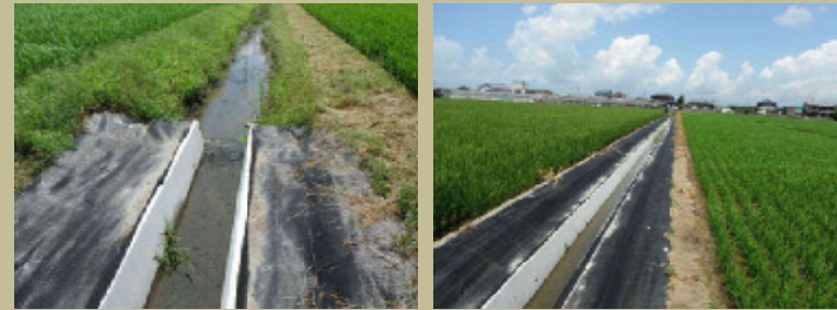
土水路 → U字溝+防草シート施工事例
