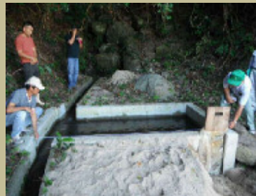
土砂溜め柵の改修
