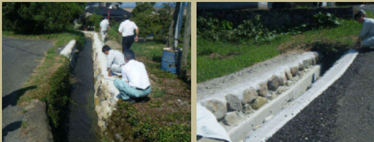
既存の石材を活用した水路改修
