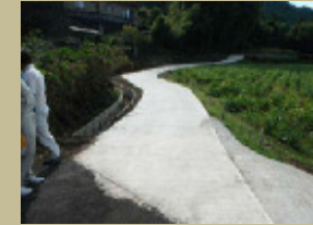
コンクリート舗装+水路更新(自主施工)
