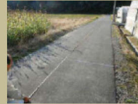
アスファルト舗装
